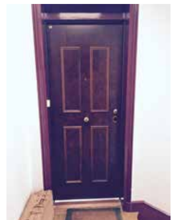
Chantier: Apenins 26 Logements Client: DOMNIS
