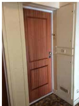
Chantier: Bagnolet 41 Logements Client: DOMNIS
