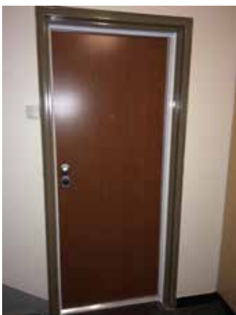
Chantier: Saint Brice Sous Foret 528 Logements Client: DOMNIS
